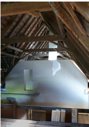
Dachraum mit Ausbau
