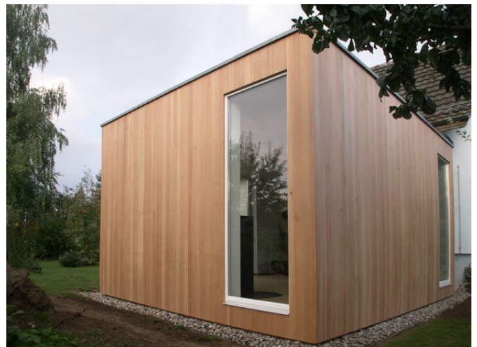
Nordostansicht der Erweiterung
