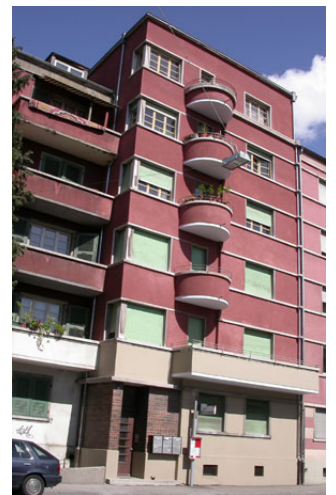
Südfassade, nach der Sanierung
