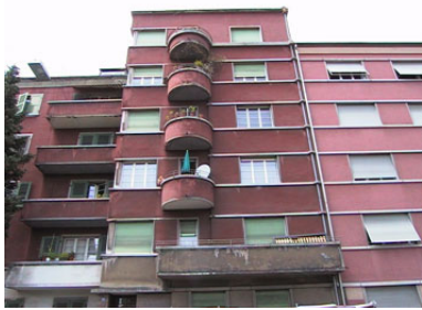
Südfassade, alter Zustand
