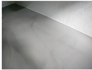
Badezimmer und Dusche, Glasmosaik an den Wänden / Giessbelag am Boden
